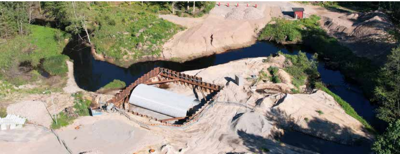
Pågående brobygge på Götgatan i Anderstorp.
